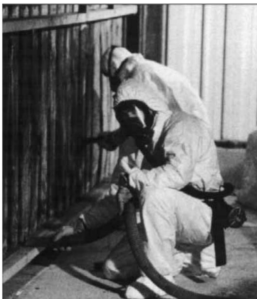
Asbestsanierung: „An die 1000 Krebstote jährlich“
